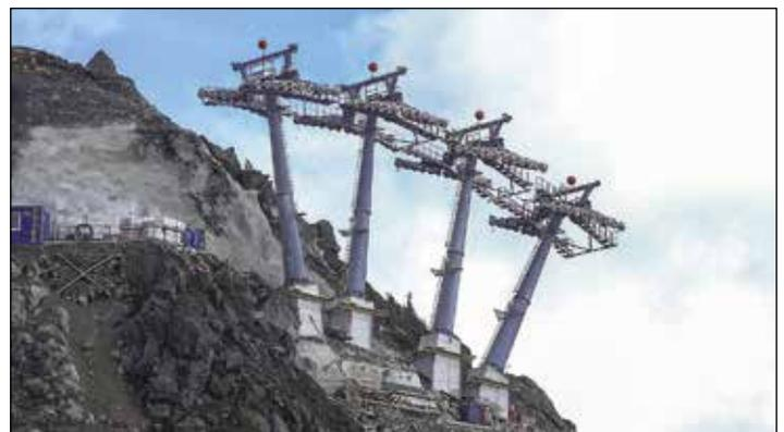
Eine besondere Herausforderung bei der baulichen Umsetzung stellte die 17er Stütze dar. Sie besteht aus vier Einzelstützen, die knapp unterhalb der Hirschkarspitze situiert sind. Für die Materialtransporte zur Spritzbetonsicherung und die Fundamente wurde eine Materialseilbahn eingesetzt. Die Montage erfolgte mit einem Schwerlasthubschrauber, der eine Hebeleistung von bis zu fünf Tonnen hat.
