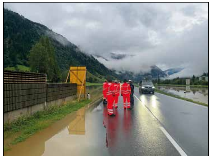
Zeitweise musste die B167 gesperrt werden.
